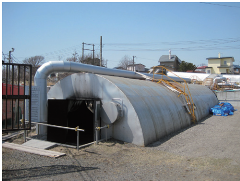
消火坑道外観
